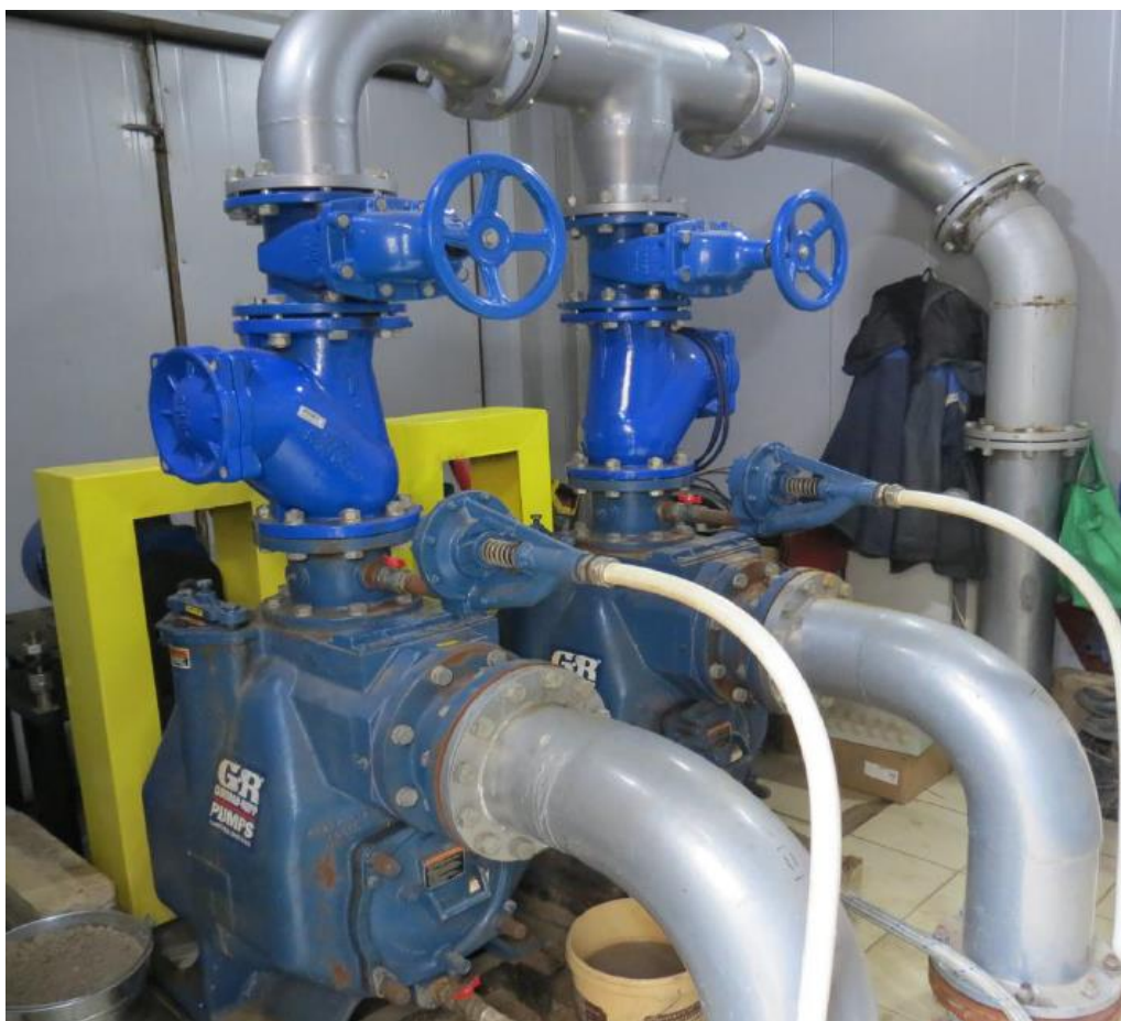
Рисунок 3 - Внутренний вид КНС-1
