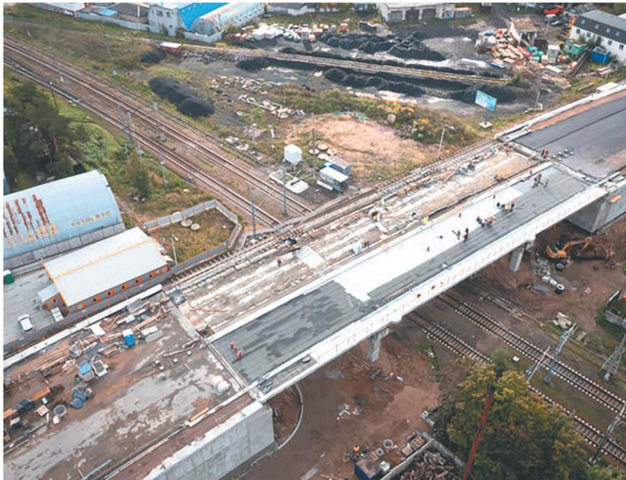
Сейчас на объекте продолжается устройство мостового полотна, ведется монтаж водоотводных лотков и конструкции тротуаров левого направления.
