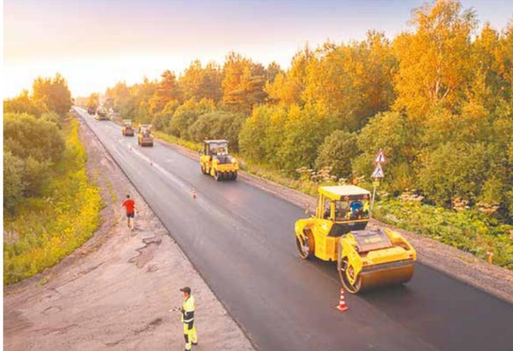
В процессе работы сотрудники подрядной организации уложат два слоя нового асфальтобетона, вычистят полосы отвода и укрепят обочины. Спецтехника уже сняла старое покрытие. Вместо него укладывают евроасфальт, который учитывает климатические особенности региона и нагрузку на дорогу.
