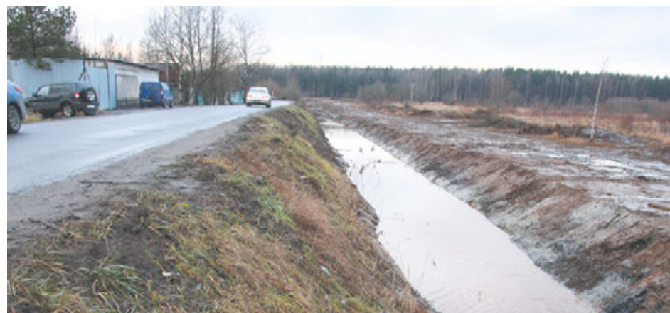
Отсутствие ограждения создает опасную аварийную ситуацию на неосвещенном повороте
